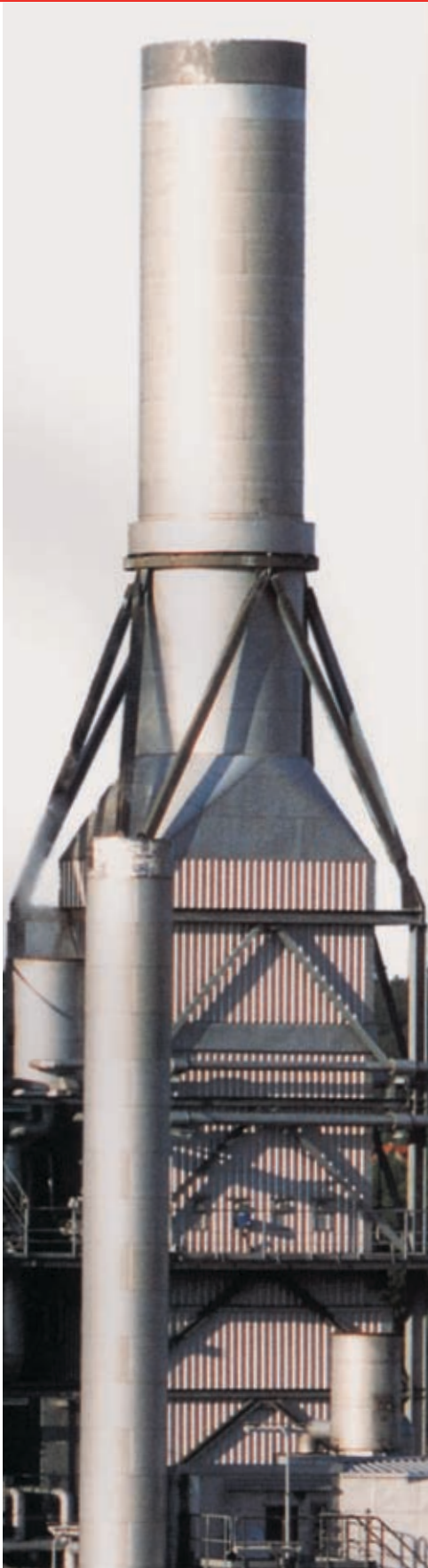
Industrieschornsteine mit mangelhafter Filteranlage sind häufige Verursacher von Verschmutzungen
